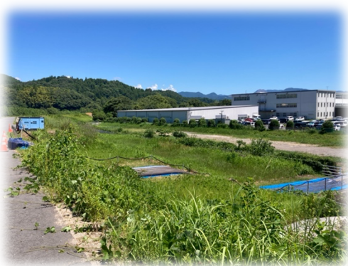
石井工業団地排水ポンプ整備予定地
